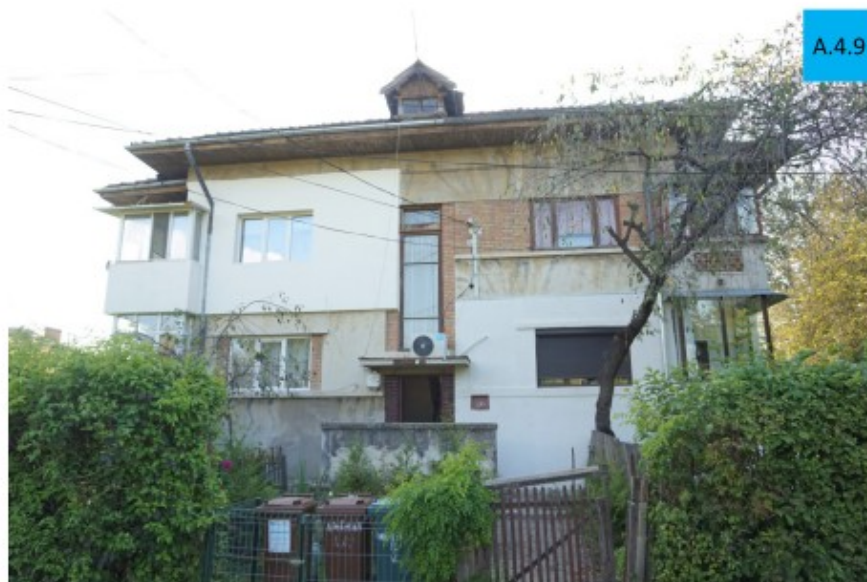
STR. PRIMĂVERII / STR. BUCEGI Tipul construcție: A.4 (VILA TIP E1)
