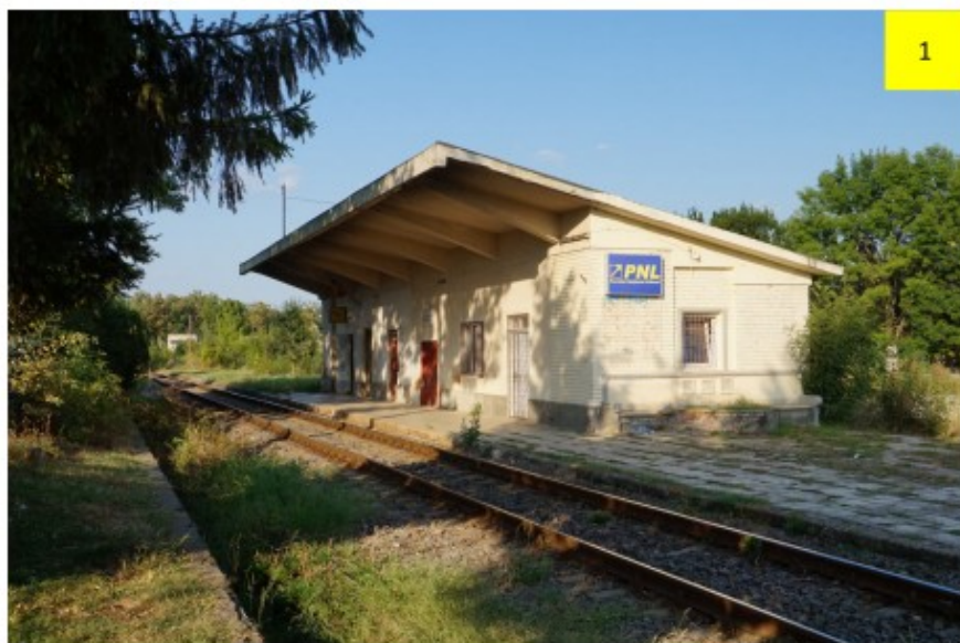
Clădirea gării situată la ieșirea din uzină. Construită în perioada 1938-1942
