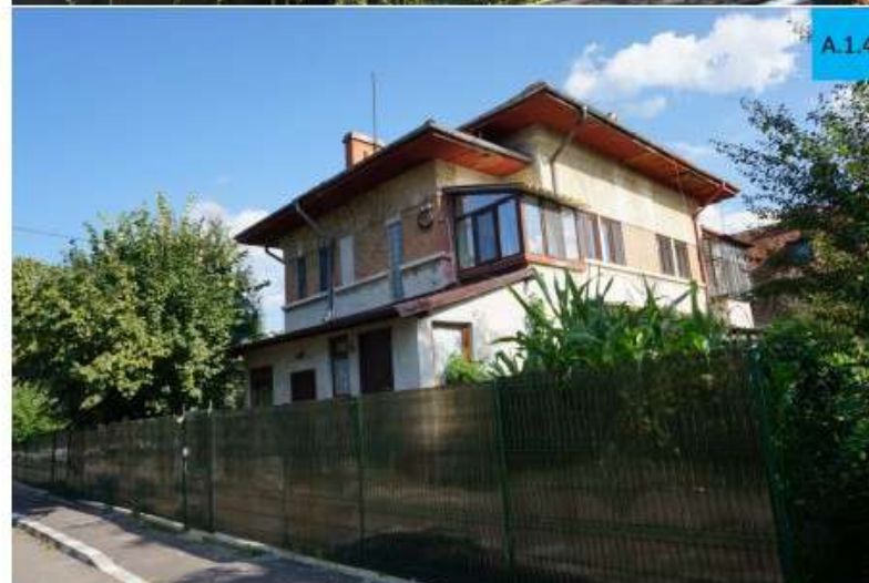
Acoperiș în 4 ape. Învelitoare (originală): țiglă solzi
